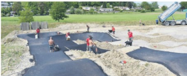
Letzten Montag wurde mit dem Asphaltieren der Wellen und Kurven begonnen. Alles in Handarbeit.
